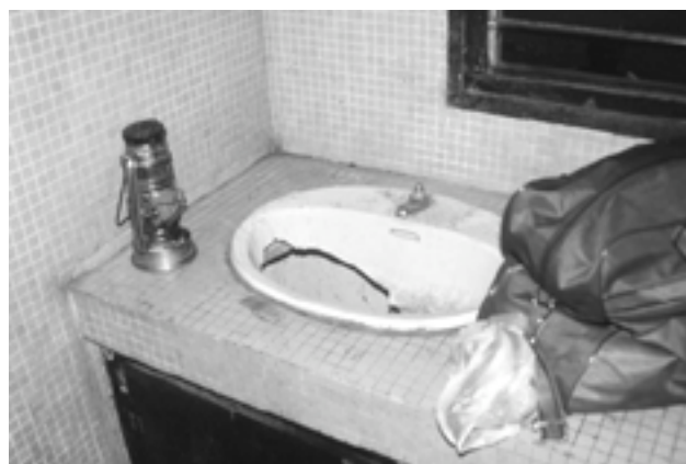
Figure 3 - Situation à haut risque nosocomial : salle de soins avec point d'eau non fonctionnel (© F. Simon).
